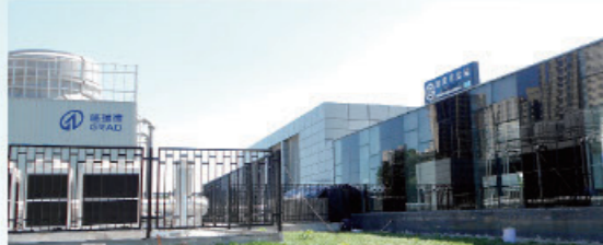
北京地铁十号线 Beijing Metro Line 10
